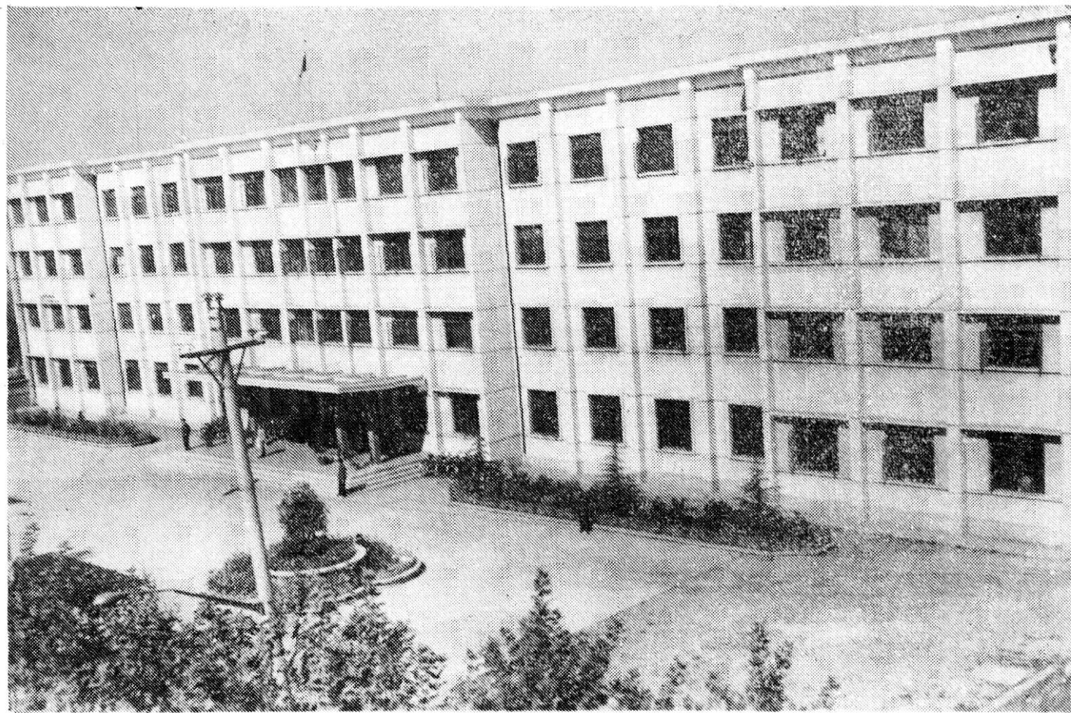
信阳县人民政府、信阳县人大常委会办公楼
