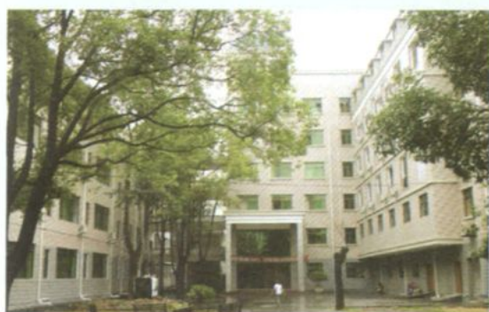
第一人民医院住院部大楼
