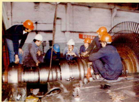
锦州发电厂机组检修
