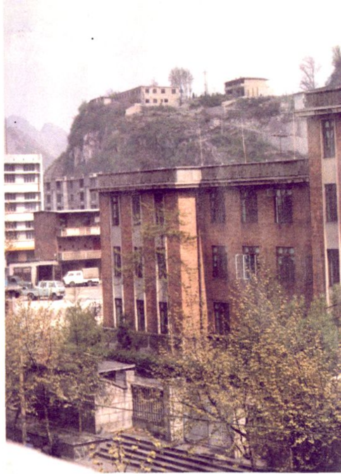
●六枝矿务局办公楼
