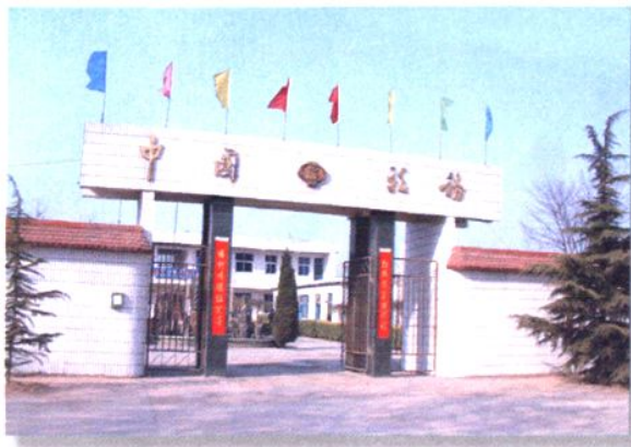
1996年10月竣工投入使用的北苏税务所，位于北苏村村北，正无路路北。
