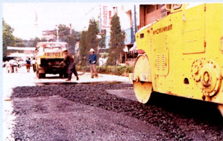
道路养护管理所进行路面维修施工（1996年）
