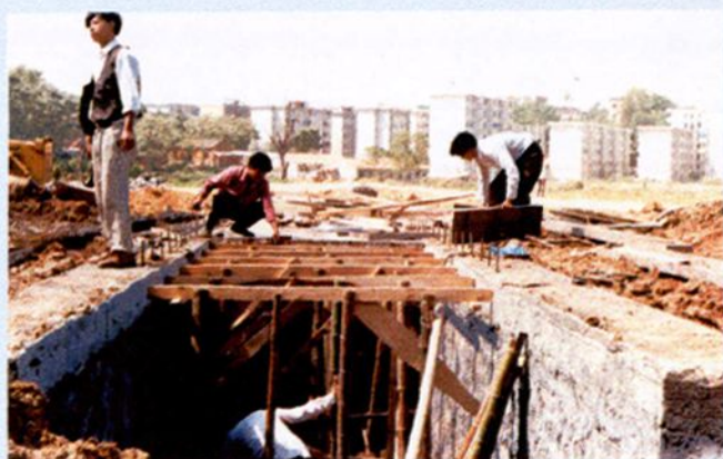
市政建管总公司进行过路涵洞施工(1996年)
