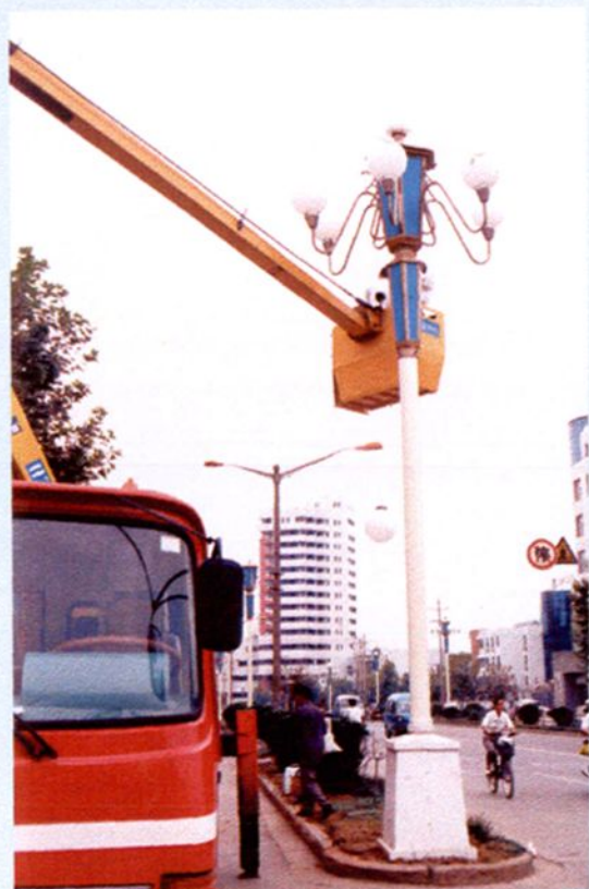
路灯管理所进行路灯安装(1996年)
