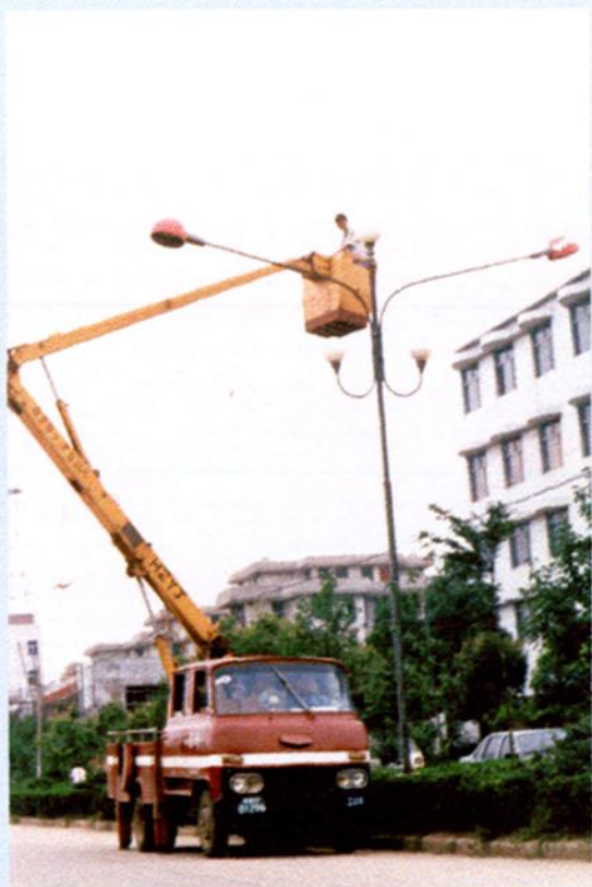
路灯管理所进行路灯维护(1997年)
