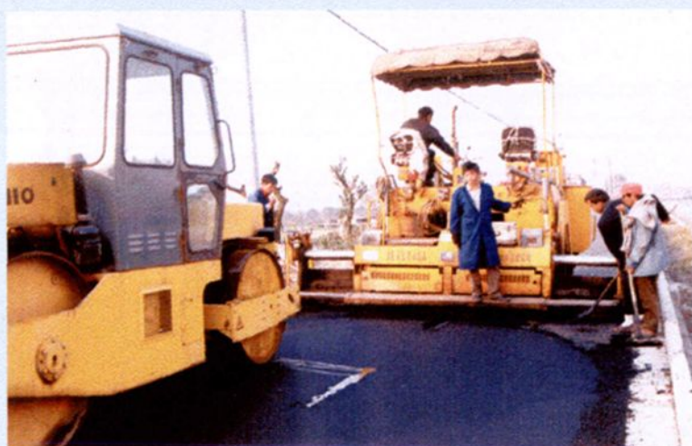
市政建管总公司进行沥青路面施工（2000年）
