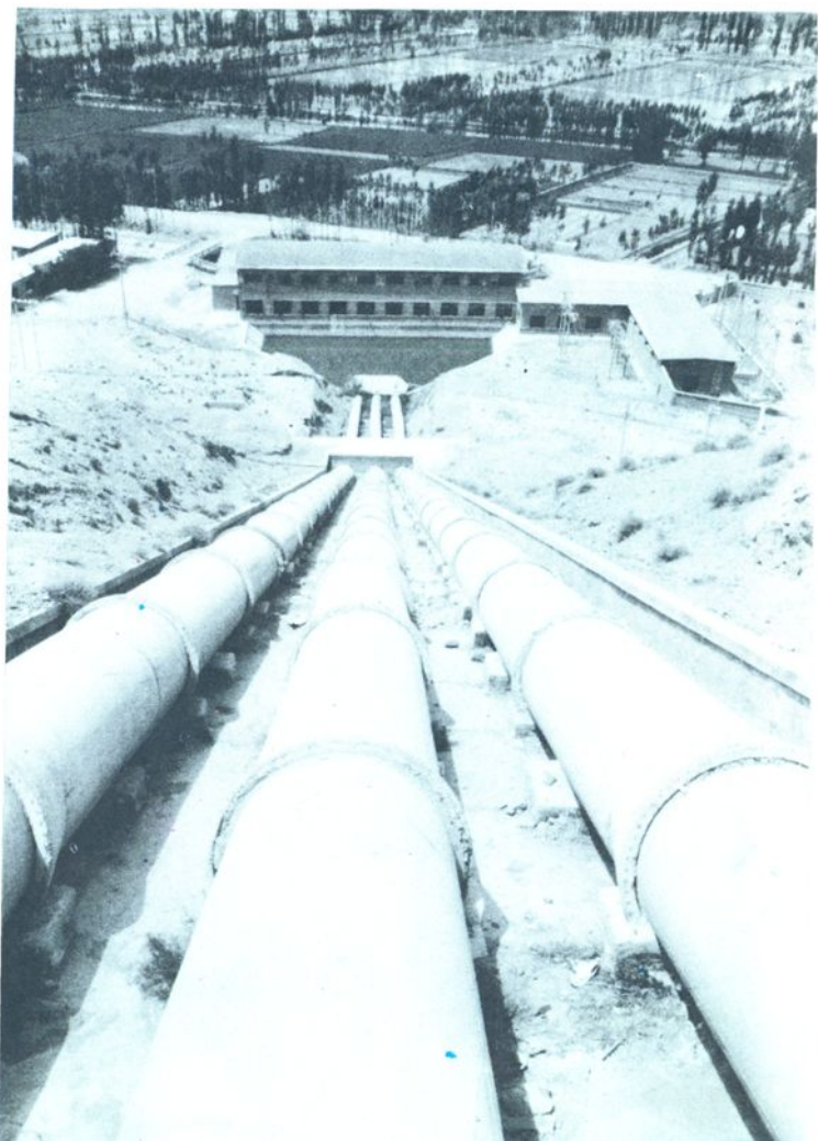
南山台子一泵站(下) 沙漠中建成的北干沟(上)
