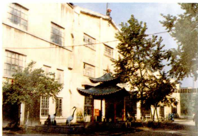
机车检修联合厂房
