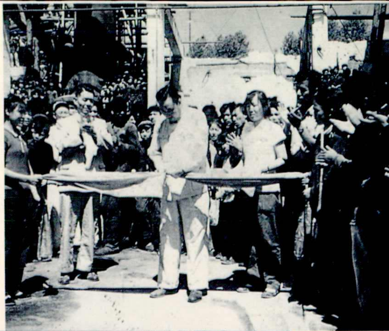
一九五八年八月一日，工厂铸钢车间建成，牡丹江市委书记沈重（左二）参加典礼，地委书记于天放剪彩。
