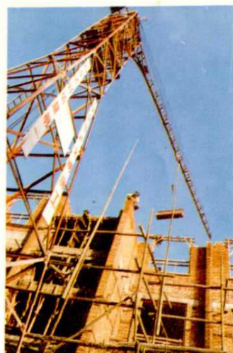
建设中的计量大楼
