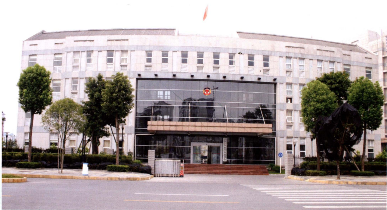
2004年12月20日永川市政协迁入人民大道191号新办公楼。
