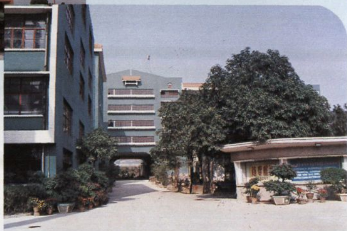
龙溪轴承厂厂区
