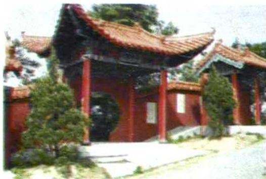
毕升公园亭廊（06年摄）
