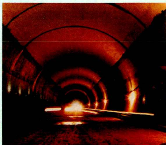
▲成渝高速公路龙泉山隧道
