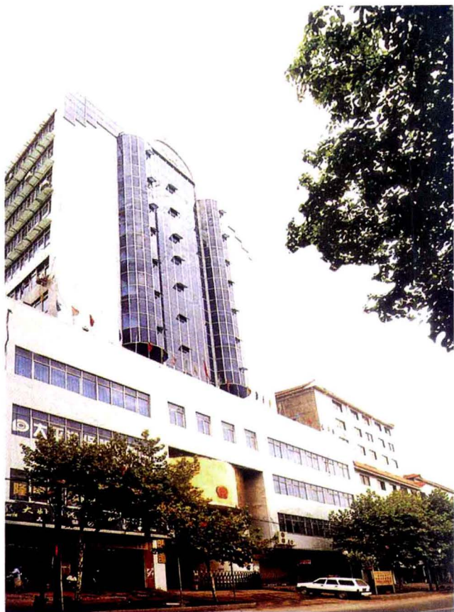
城南区机关办公大楼
