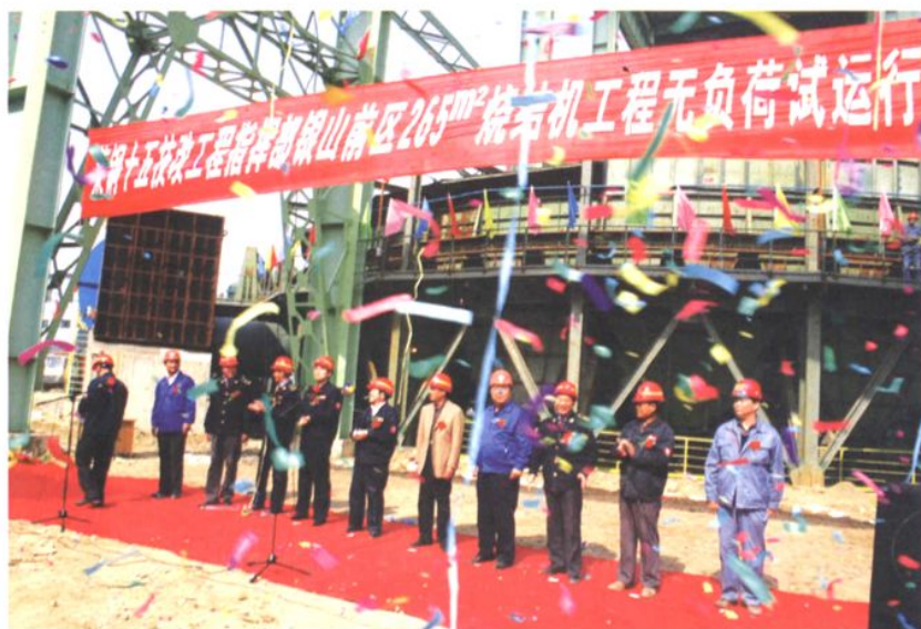
2005年10月15日，银 山前区 265 平方米烧结机 进行无负荷试运行。
