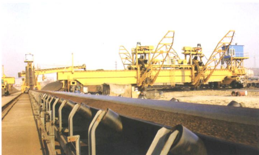
混匀堆料机、 混匀取料机
