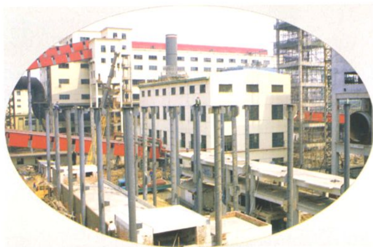
建设中的银山型钢区 1号265平方米 烧结机。
