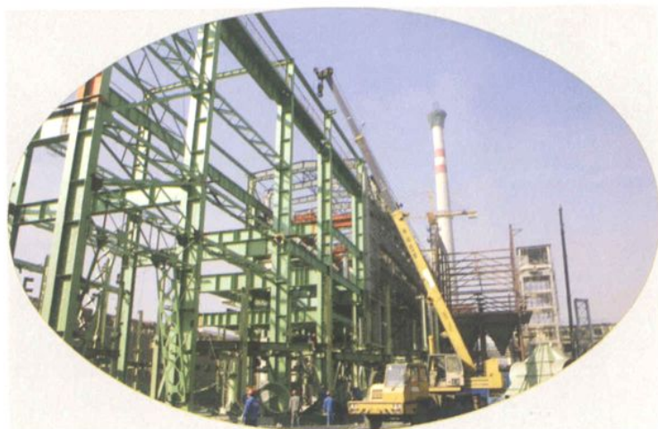
建设中的银山型钢区 1号265平方米 烧结机。
