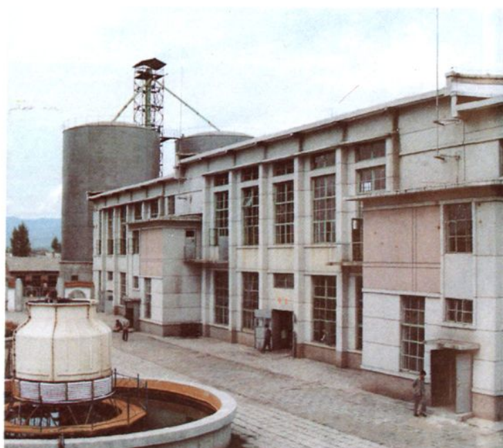
植物油厂浸出车间
