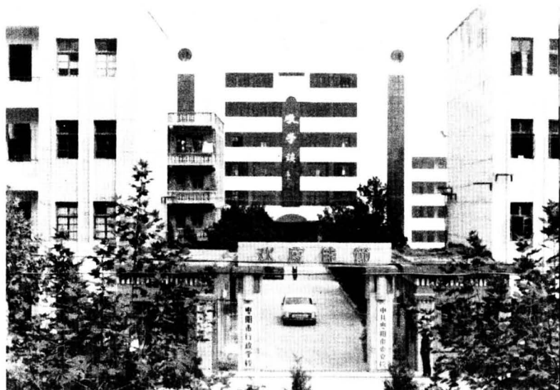
枣阳市委党校教学楼
