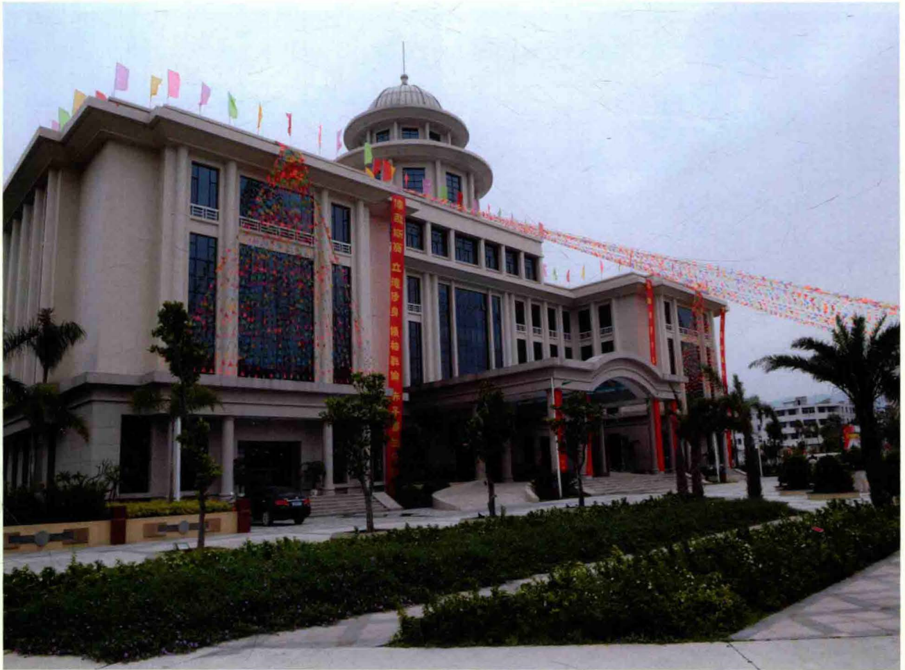
庄世平博物馆（2009年建，位于环城南路北侧）
