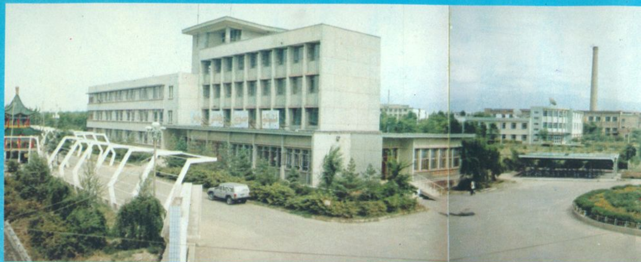
矿务局办公大楼
