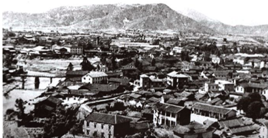
1949 年前龙岩城区面积不足 1 平方公里,人口不足 1 万。图为旧城貌
