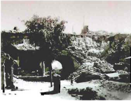
1920年海原8.5级地震，固原城墙崩坏，前提督署赏门塌坏，墙倒架在
