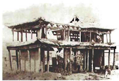
1920年海原8.5级地震，固原城墙崩坏，前提督署赏门塌坏，墙倒架在
