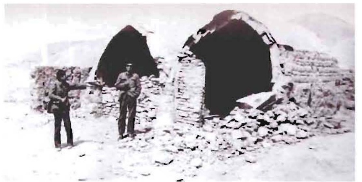
1982年海原5.5级地震，造成公路边长达180m的滑坡，土坯拱窑被破坏
