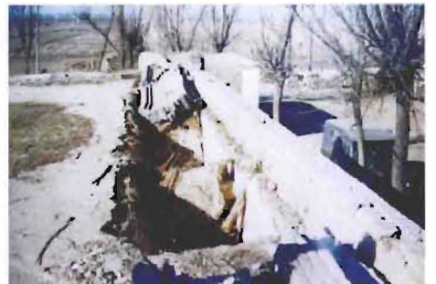
1988年灵武5.5级地震，出现喷砂冒水（左）；女儿墙砸塌房顶（右）
