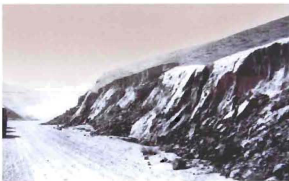
1982年海原5.5级地震，造成公路边长达180m的滑坡，土坯拱窑被破坏
