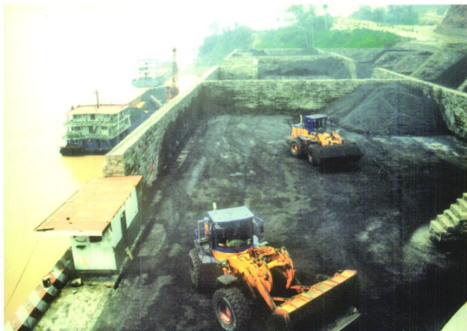
重庆市泰丰（集团）投资公司投资建设的渝西货运港码头（永川港区松溉作业区一期工程）。
