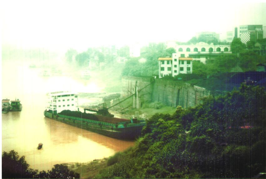
二〇〇六年十月，正在作业中的永川利亚达港埠有限公司码头。
