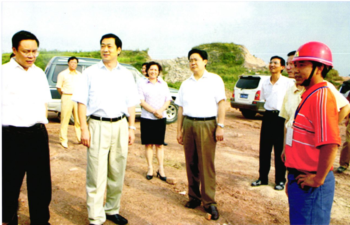
二〇〇六年八月，中共永川市委、永川市人大、市政府、市政协主要领导视察一环路施工现场。
