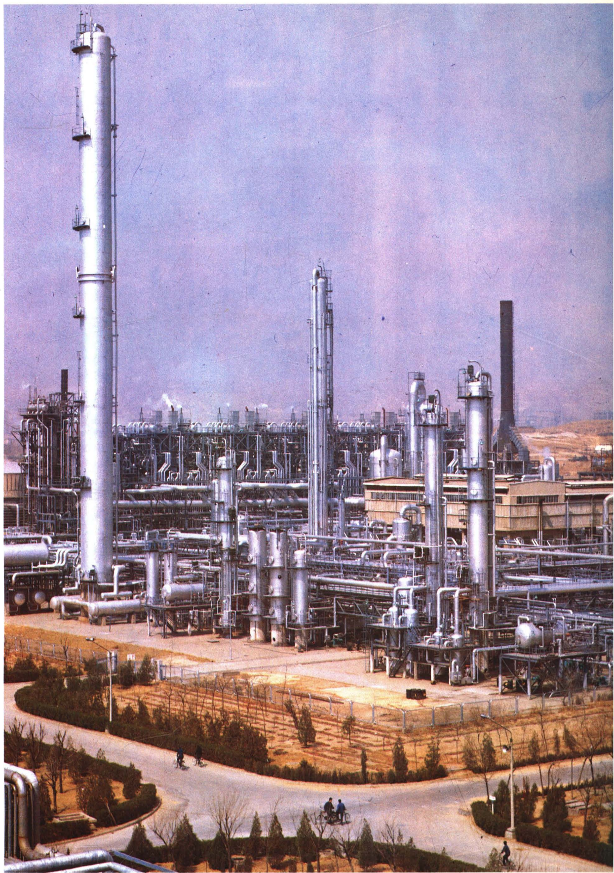
燕山石油化工公司一角
