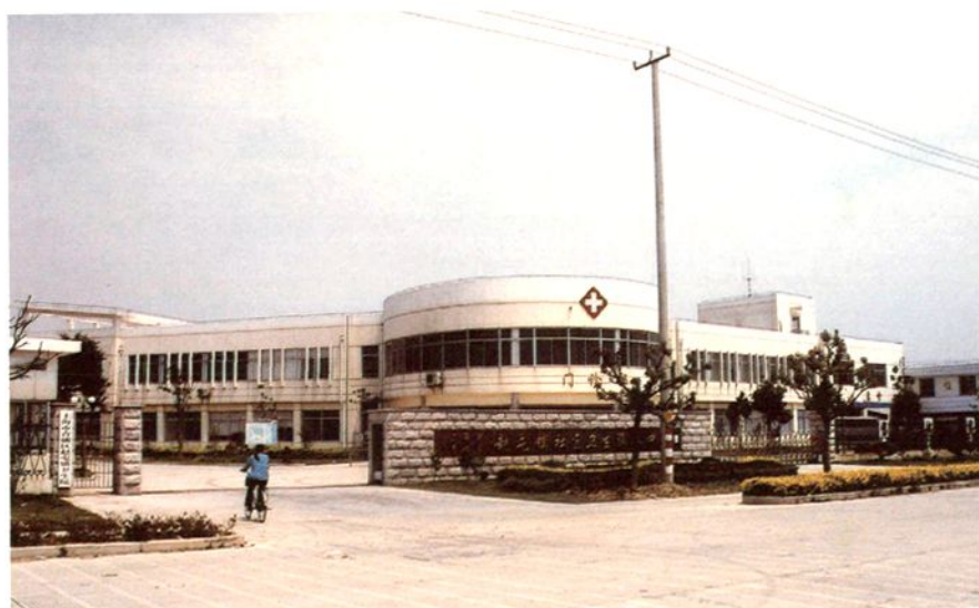
2003年新建的上海市青浦区赵屯镇卫生院
