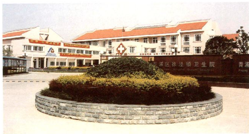
2001年竣工的上海市青浦区徐泾镇卫生院为上海市郊区规模最大的镇级卫生院
