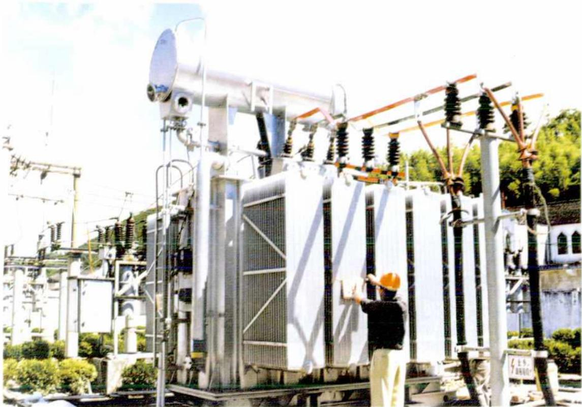
35 千伏大溪变电所 2 万千伏·安变压器
