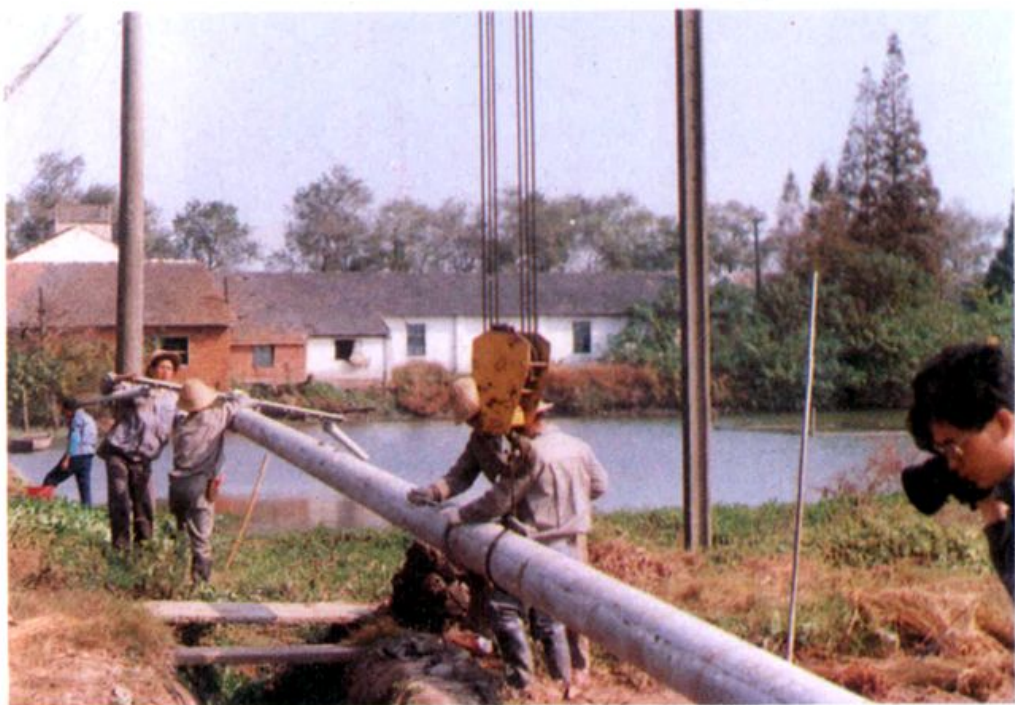
线路工正在起吊电杆
