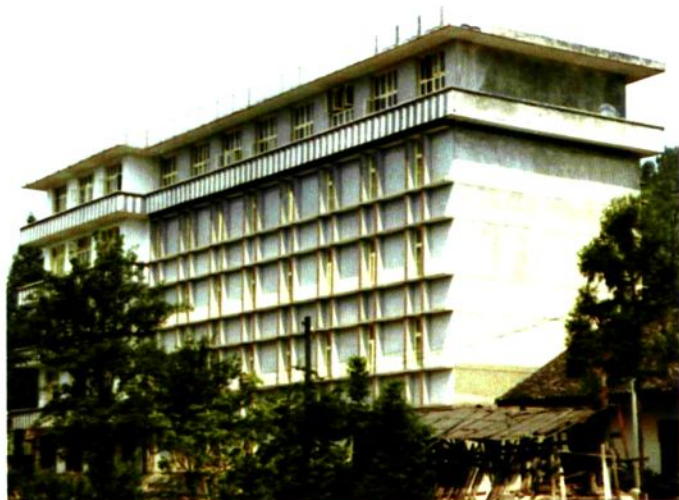
图 17 1985 年,建设中的利川县档案馆。
