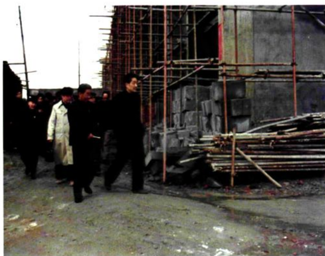
图13 1987年3月19日,在鄂全国人大代表和湖北省人大常委会委员视察湖北省档案工作。图为察看湖北档案馆新馆舍建筑工地。
