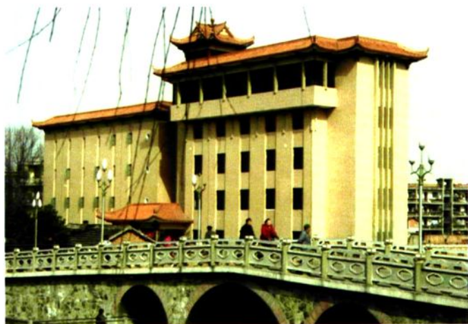
图 18 1990 年,投入使用的随州市档案馆新馆舍。
