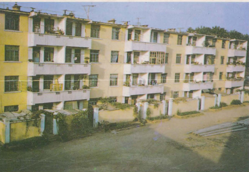
电业局宿舍楼
