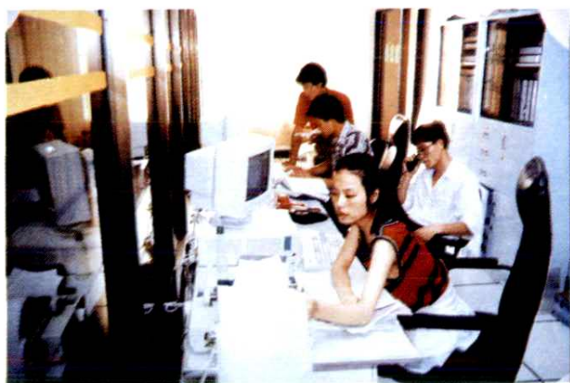
► 程控电话机房
