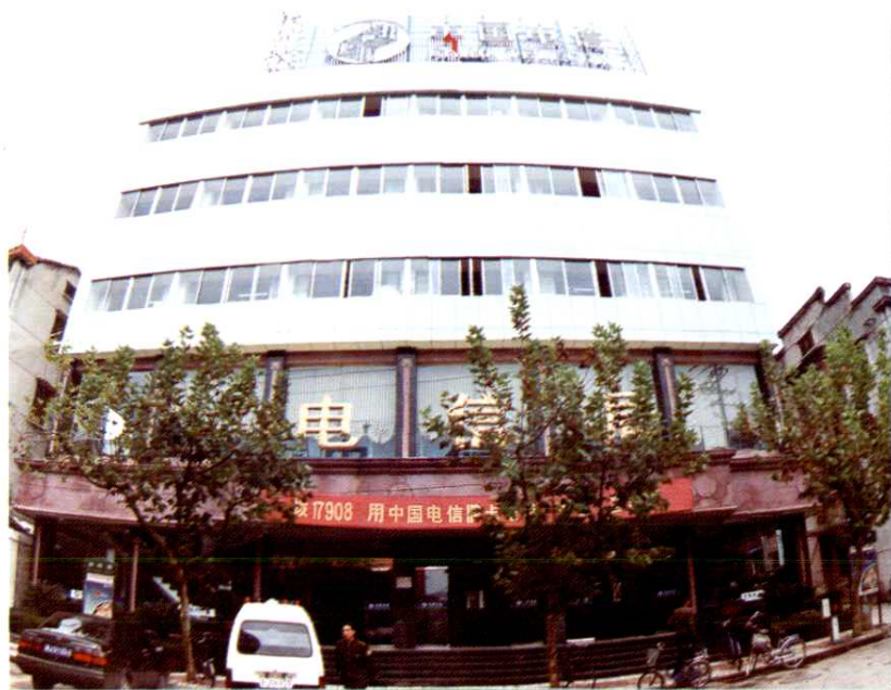
► 玉环电信大楼
