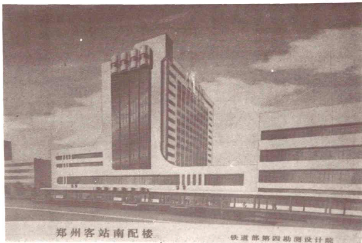
郑州客站南配楼
