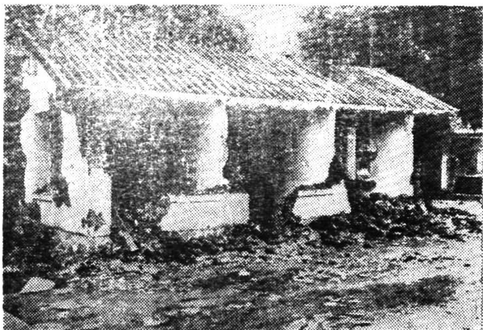
照片1：潞西县芒市机械厂医务室墙塌瓦落
