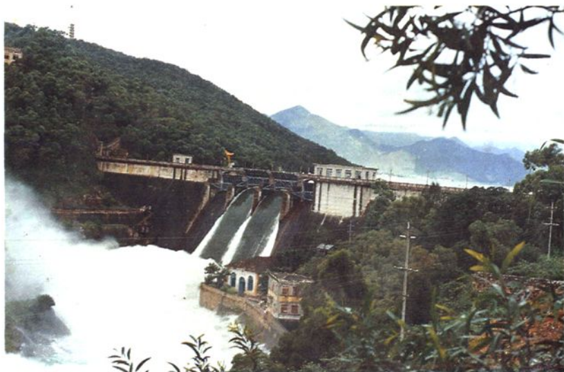
东张水库大坝排洪
