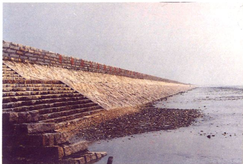
◀ 新厝海堤长 11.68 公里, 堤顶高程 6.2 米, 防浪墙高 1 米, 保护耕地面积 2.07 万亩, 始建于 1993 年 11 月, 至 1996 年 3 月竣工
