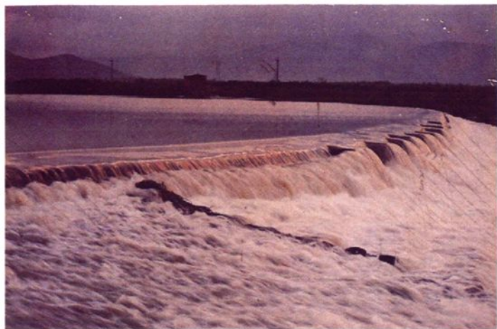
◀ 天宝陂引水工程大坝溢洪
