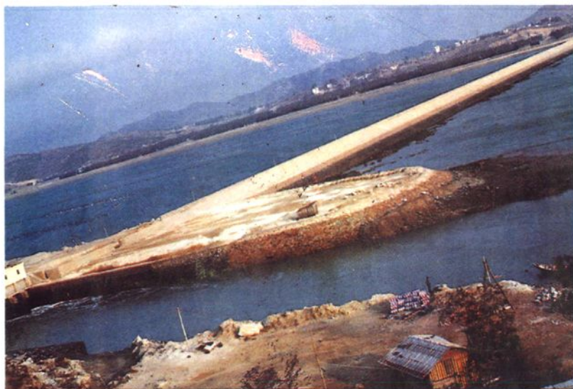
过桥山围垦工程软基础处理： 水上打设塑料排水带
