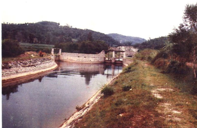
东张水库高干渠玻璃岭控制闸
