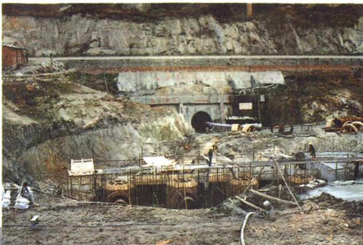
◀ 在建设中的闽江调水工程进水隧洞和水泵站
