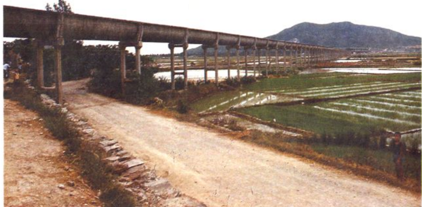
建新水库引水至江阴岛的渡槽
