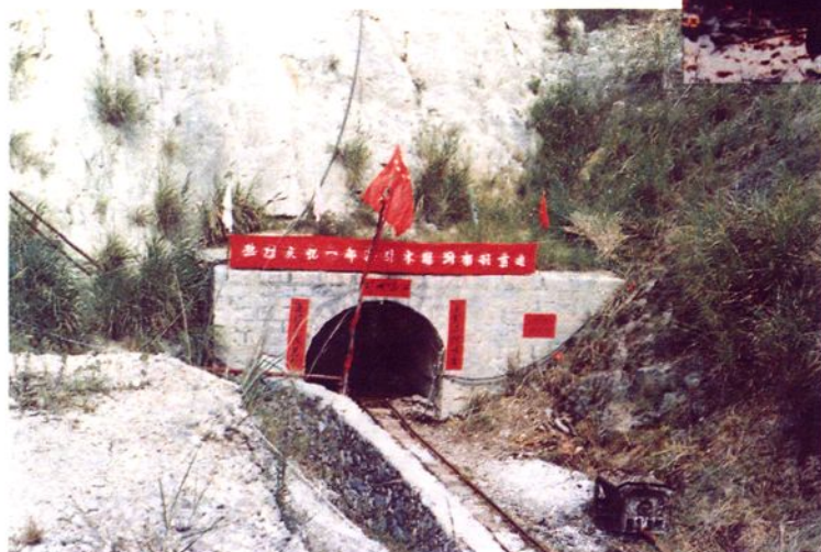
▼ 一都溪引水工程隧洞出口
