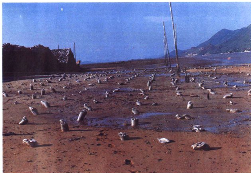
过桥山围垦工程软基础处理： 袋装砂桩施工现场
