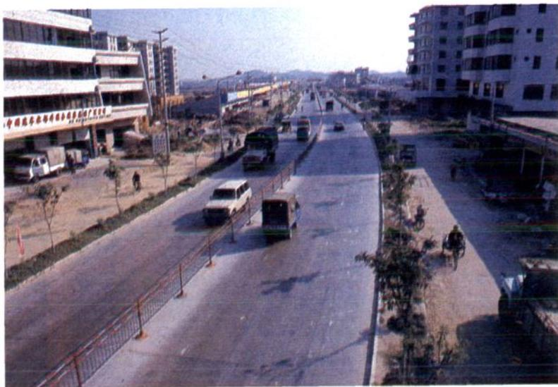
广番公路之大石路段，1990年初改造为混凝土路面，总宽33米，其中：机动车道15米，两边绿化带各1.7米，两边非机动车道各7.3米。
