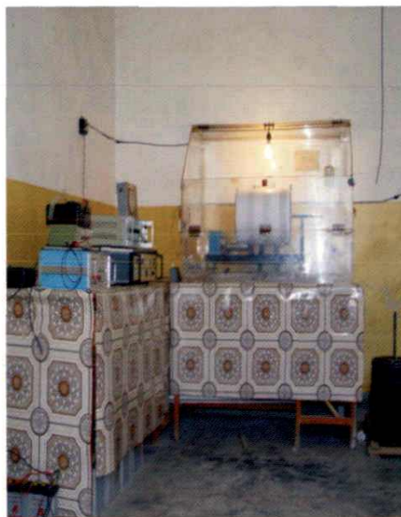
日喀则地震台模拟记录室
