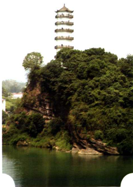
修缮一新的北塔
