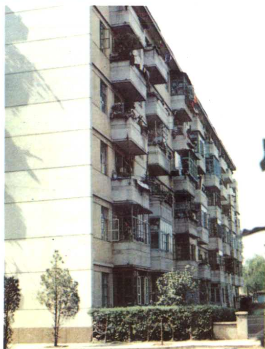
河东小区邮电职工住宅楼
