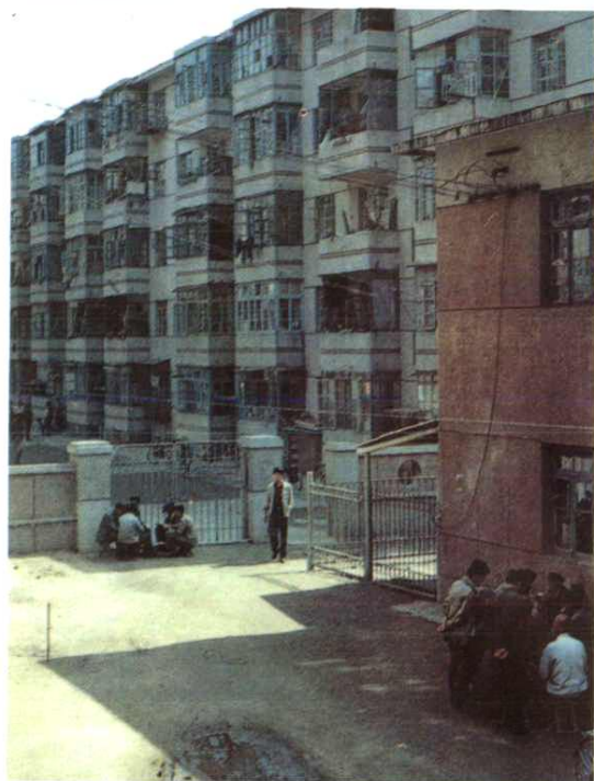
新华街怀德路邮电职工住宅楼
