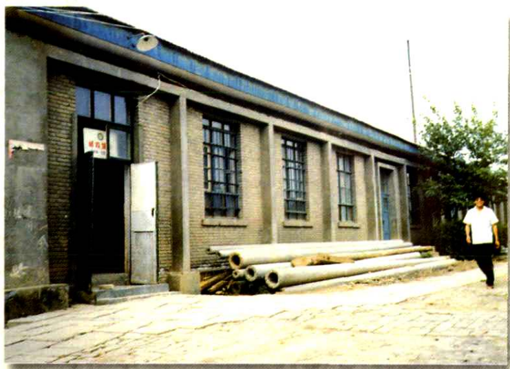
1966年建成的京—呼—兰 长途干线中宁载波增音站
