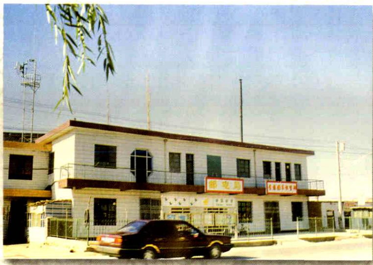
鸣沙支局通信楼 (1988年9月建成)
