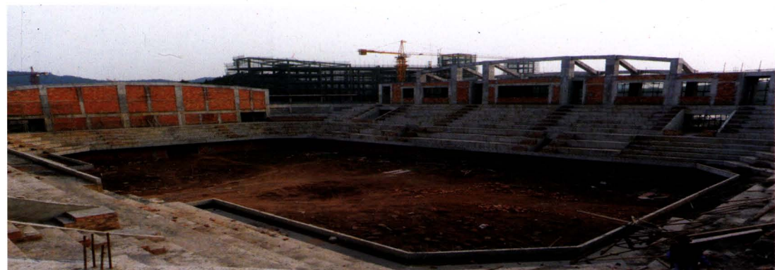
正在建设中的文化馆、图书馆、博物馆、体育馆
