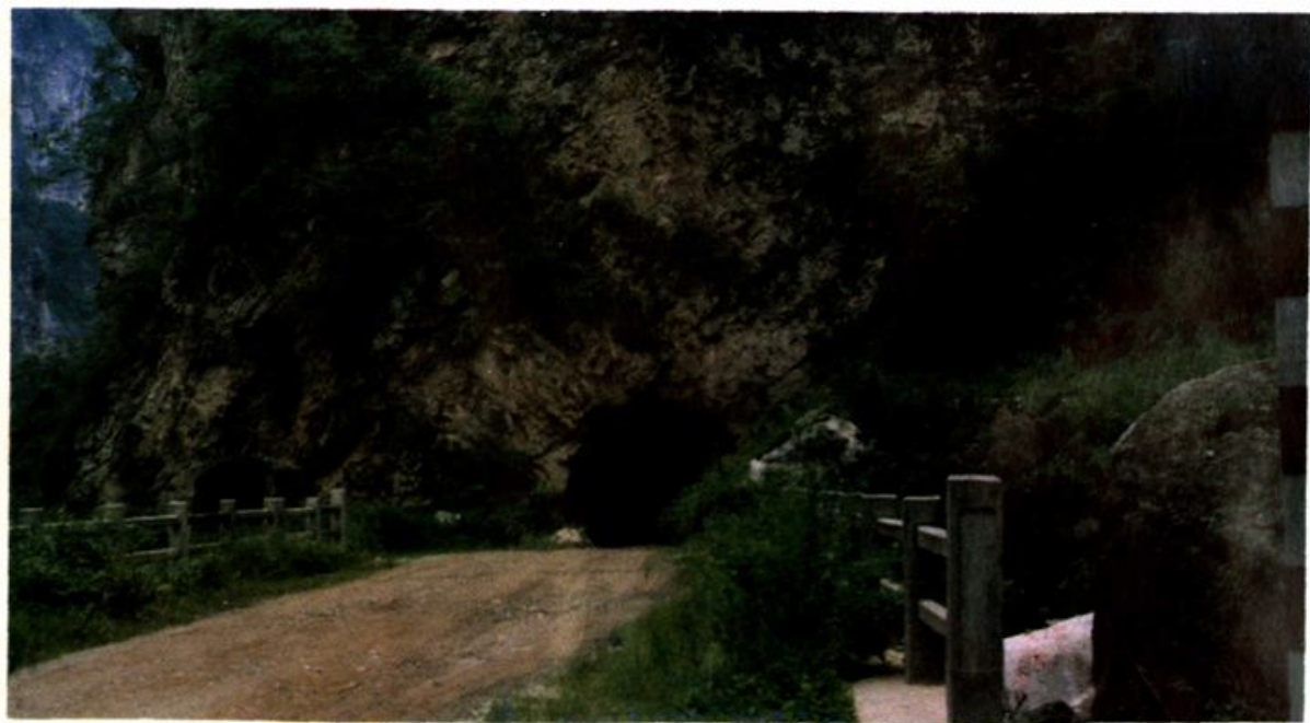
白熊溝公路隧道
