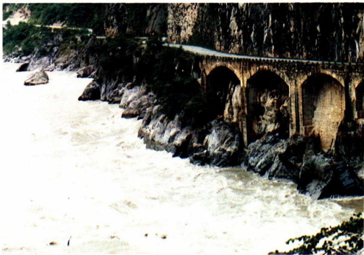
懸崖險道（石棉半邊橋）
