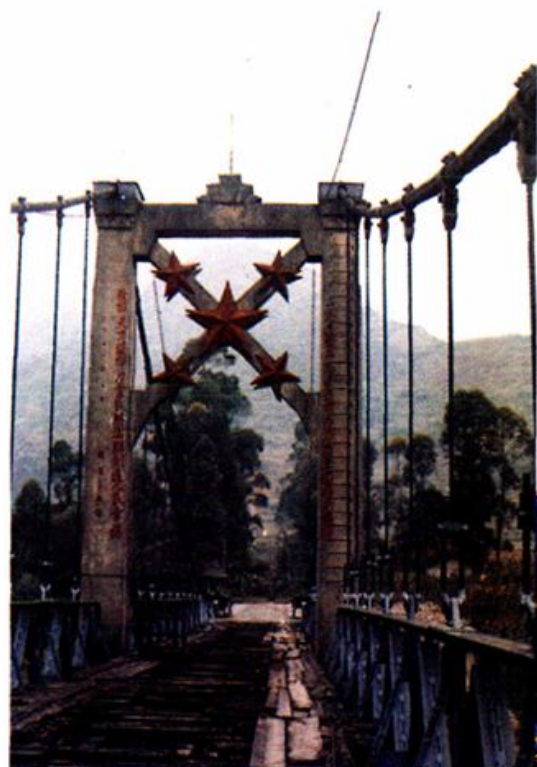
飛仙關鋼索吊橋
