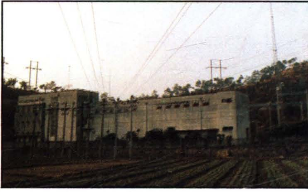
110千伏大汾变电所
