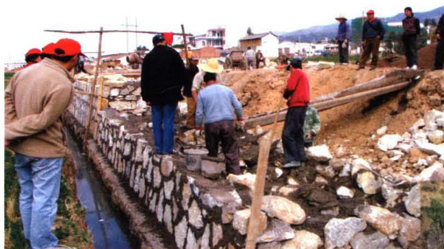
关巍公路升级改造坝区段施工现场
