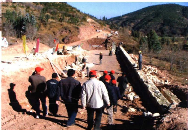
关巍公路升级改造山区段施工现场
