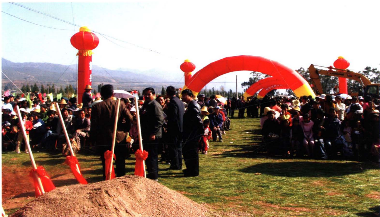
关巍公路升级改造开工仪式
