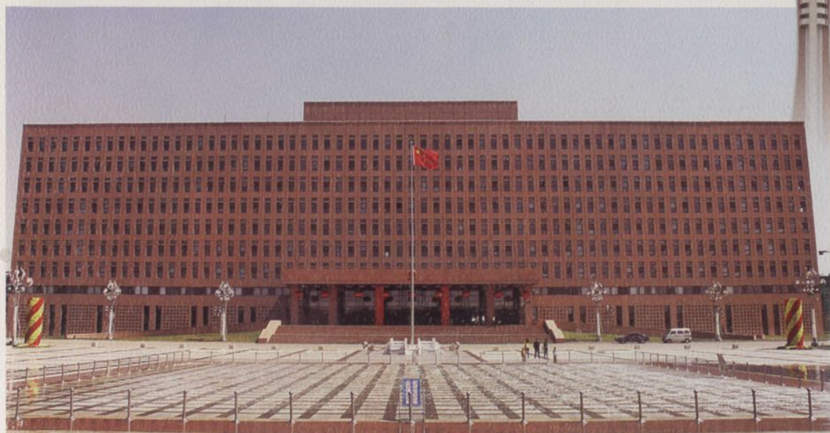
青山区党政办公大楼
