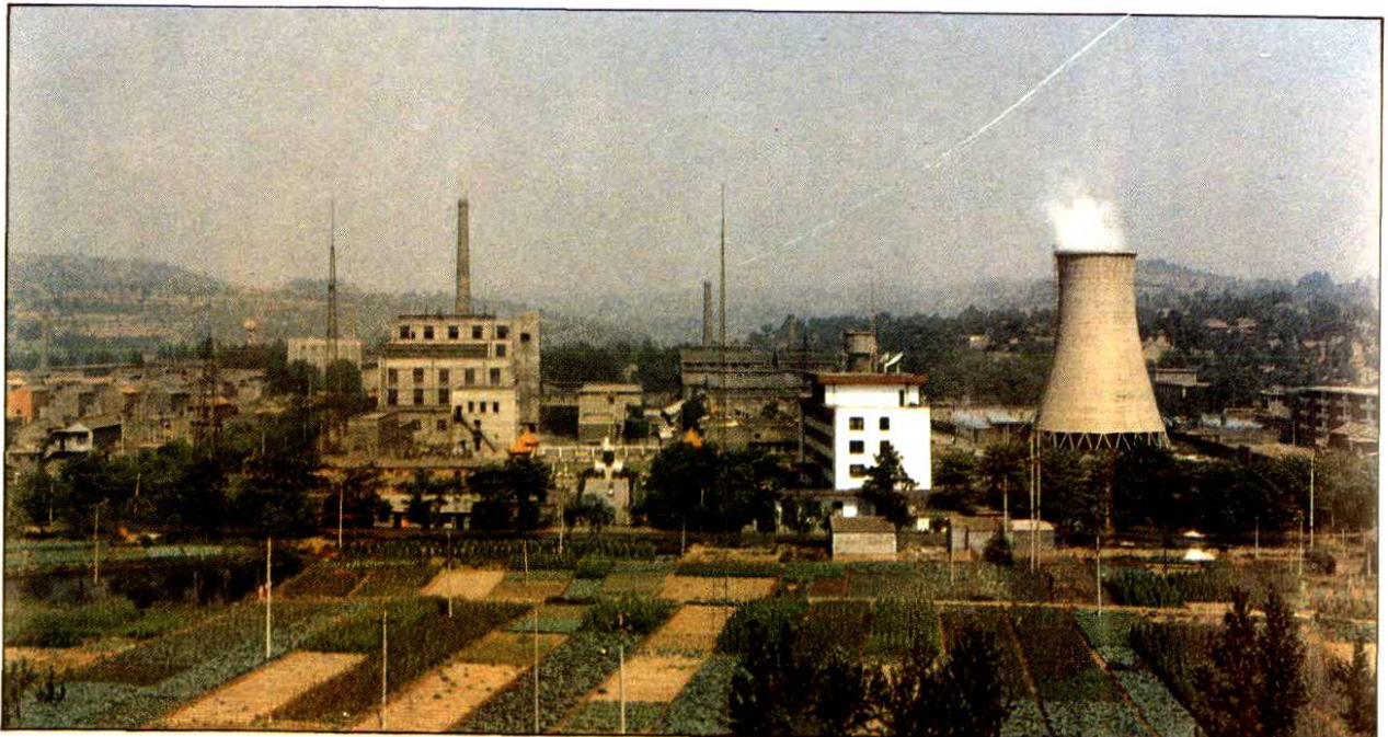
阳城电厂厂区
