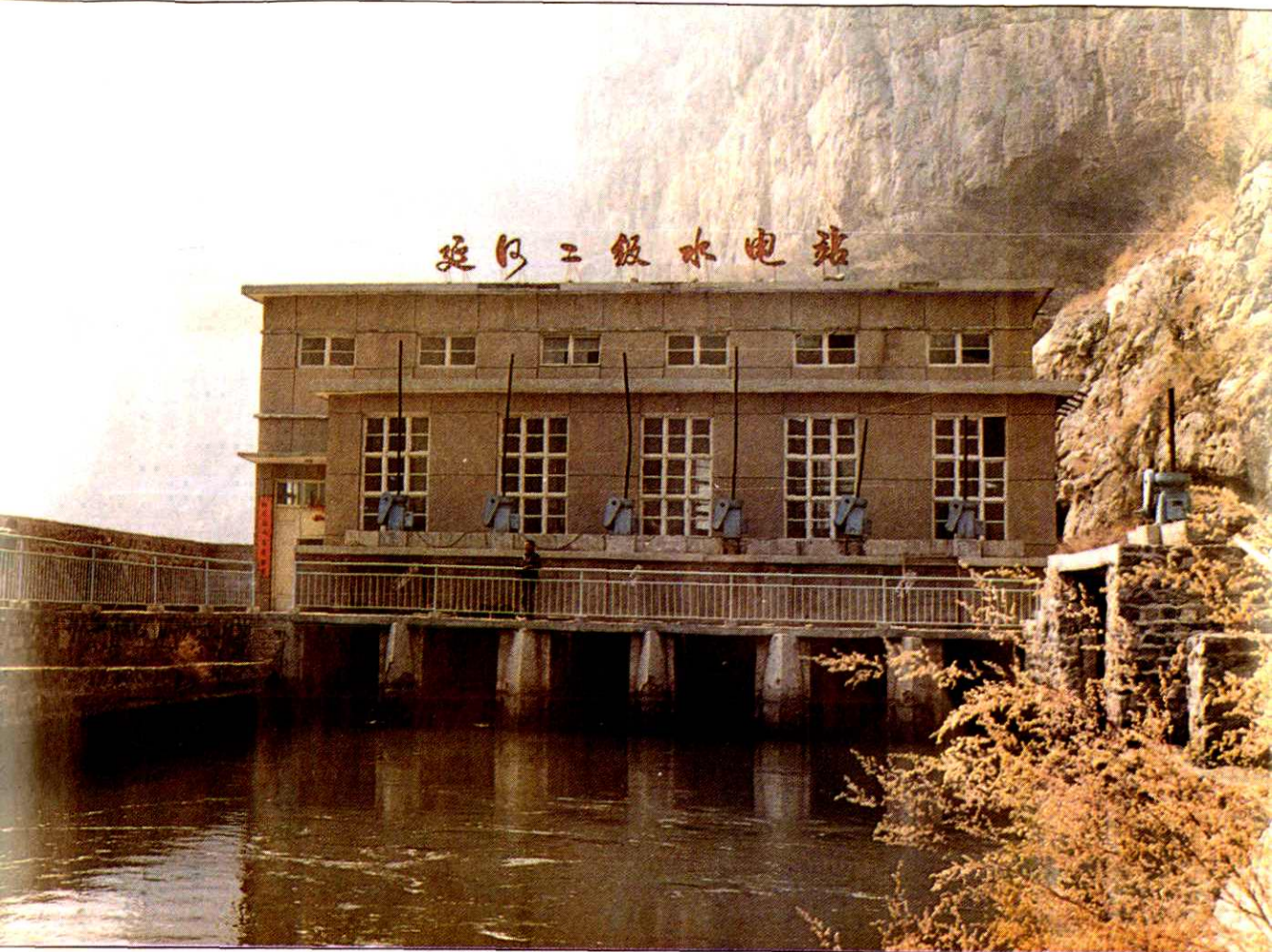
延河二级水电站
