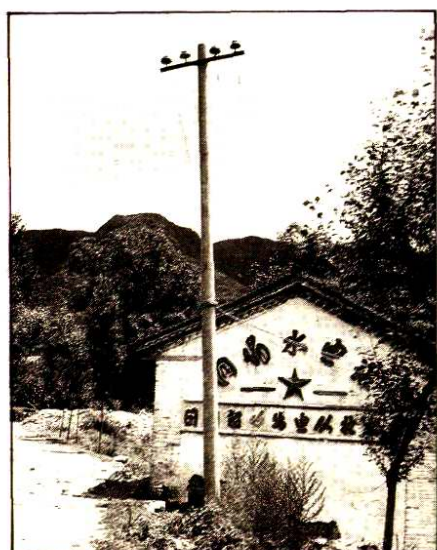
横河乡水头村向阳水电站
