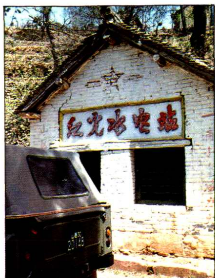
横河乡水头村 1.5 千瓦电站 —— 红光水电站
