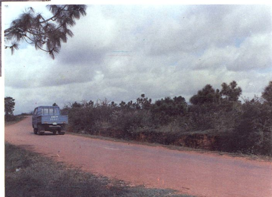
县区公路柏油路面
