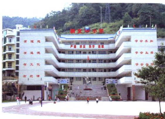
新文小学（整体置换后）
