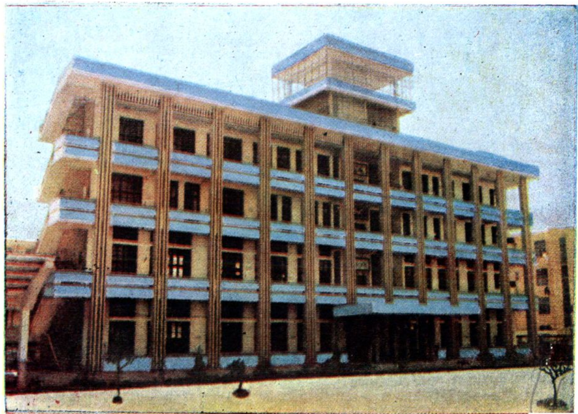
△ 苍南县邮政大楼
