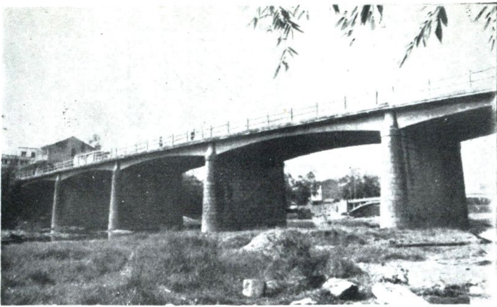
◁ 桥墩公路大桥
