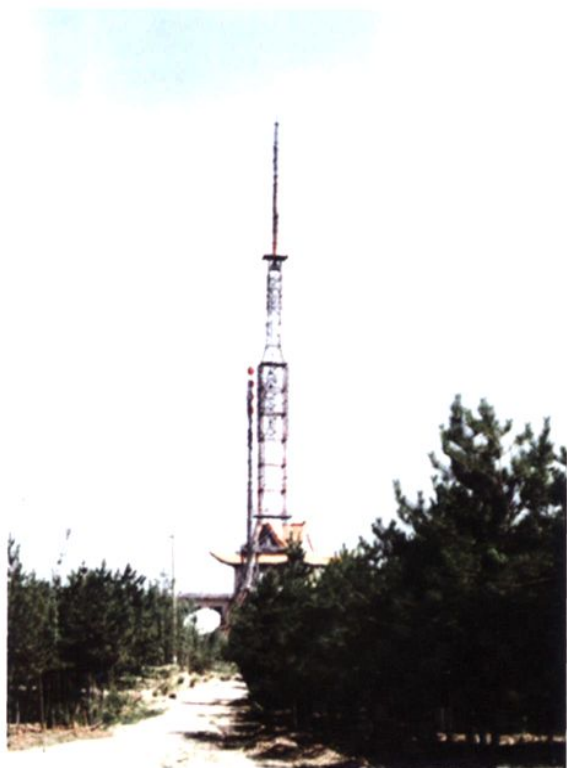
1985年3月，甘肃省广电厅无线处天线队第一次独立完成687台74米轻型自立塔的架设任务，用双环天线发送调频广播节目
