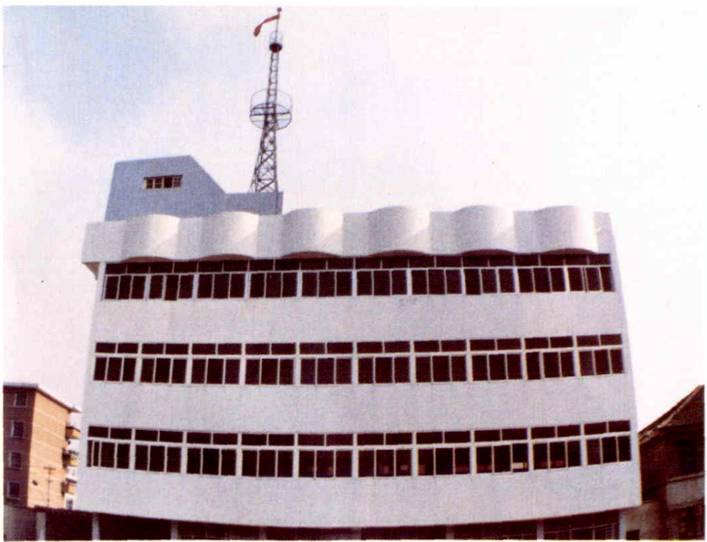
淮南发电总厂电视中心
