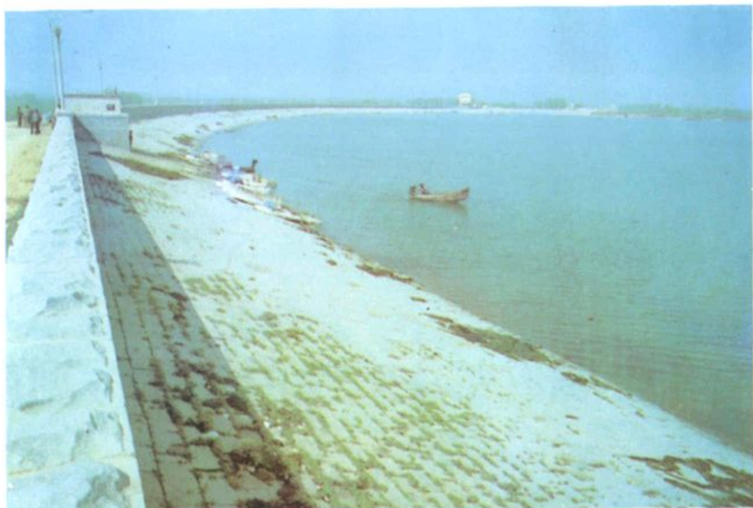
高格庄水库大坝
