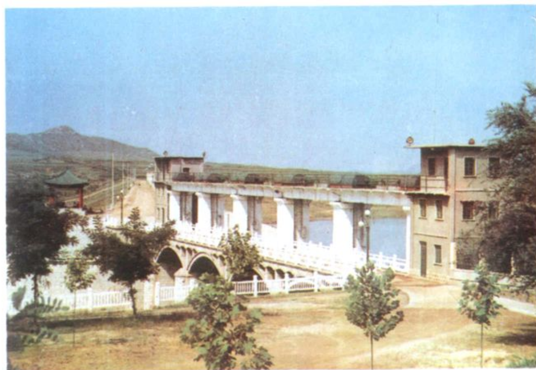
北墅水库溢洪闸
