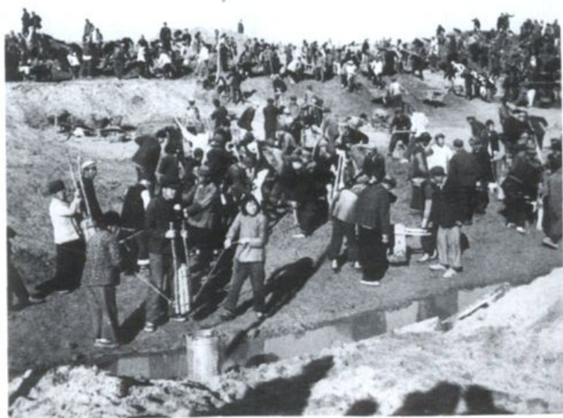
产芝水库大坝回填
