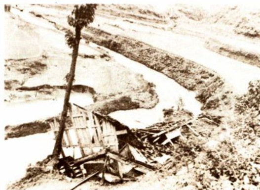
洞铁花桥水碾被洪水冲坏
