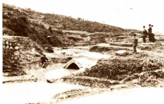
山洪冲毁香坪利朋桥现场
