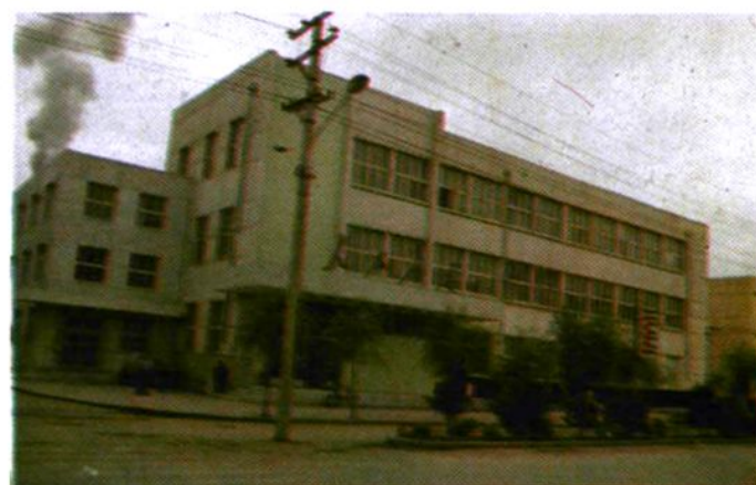
铁岭市清河区邮电局楼
